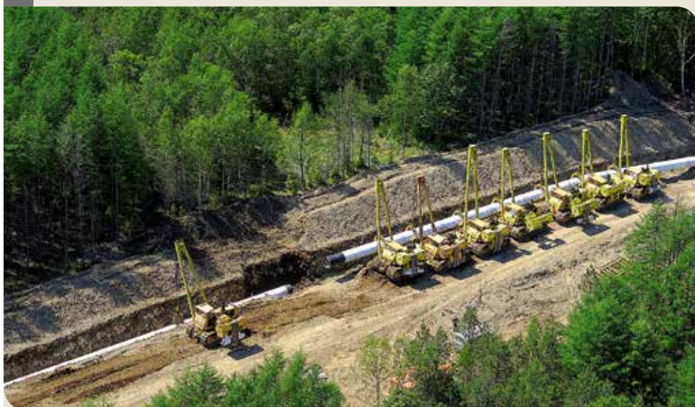
Строительство магистрального газопровода Gas main being constructed
